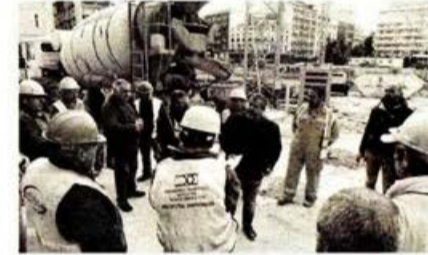
Στα εργοτάξιο του Μετρό στο Δημοτικό Θέατρο Πειραιά
